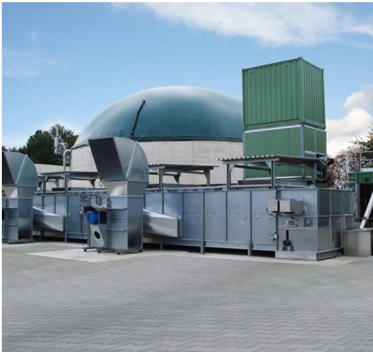
Рис. 1.4. Сушарка сільськогосподарської продукції на біогазі на біогазі [13]
