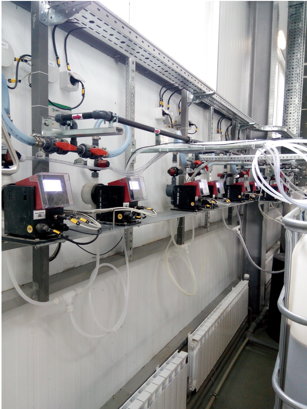
Рис 3.2. Насоси дозатори та датчики дозування та вимірювання
