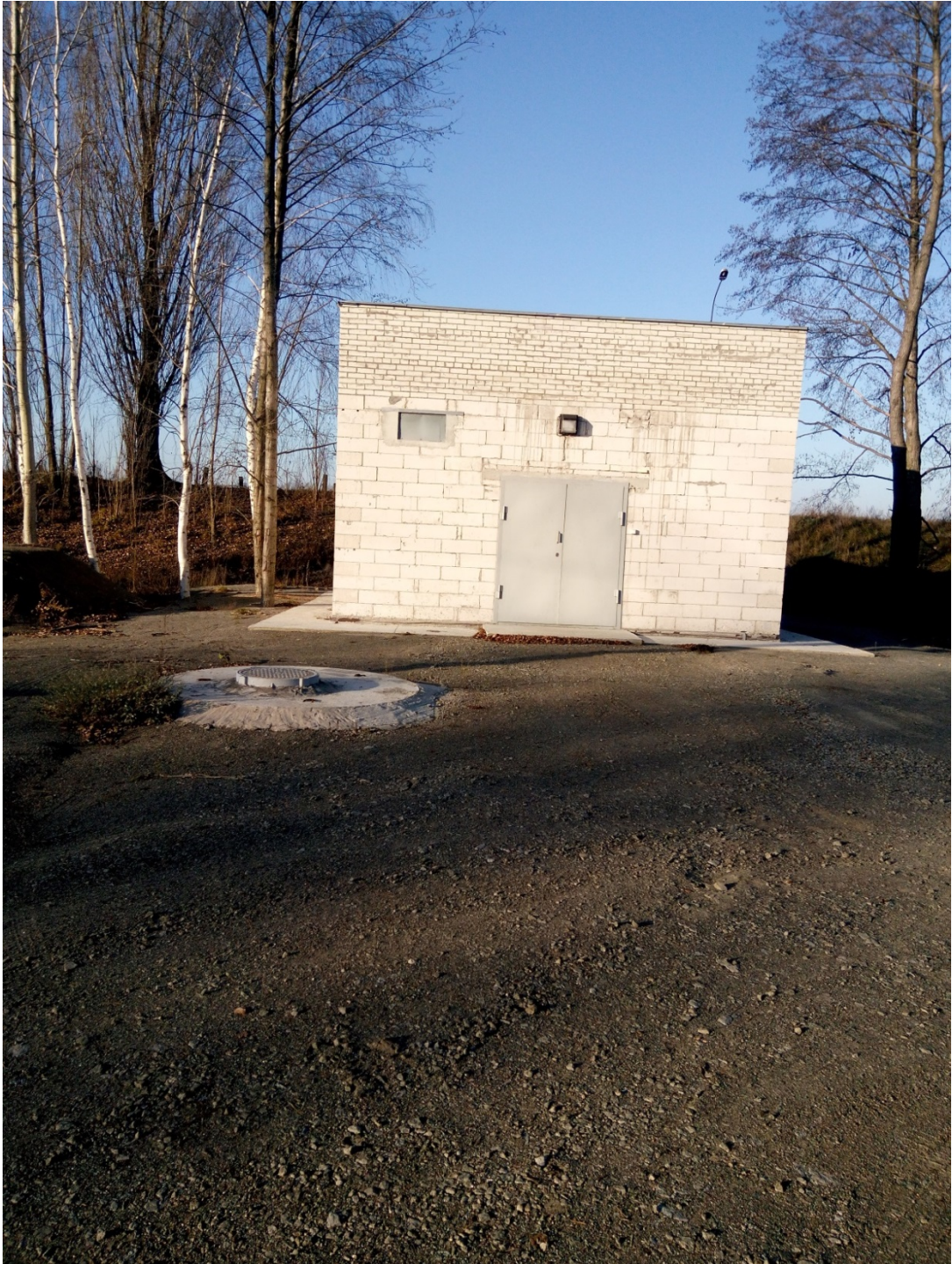
Рис 2.3 Будівля станції першого підйому
