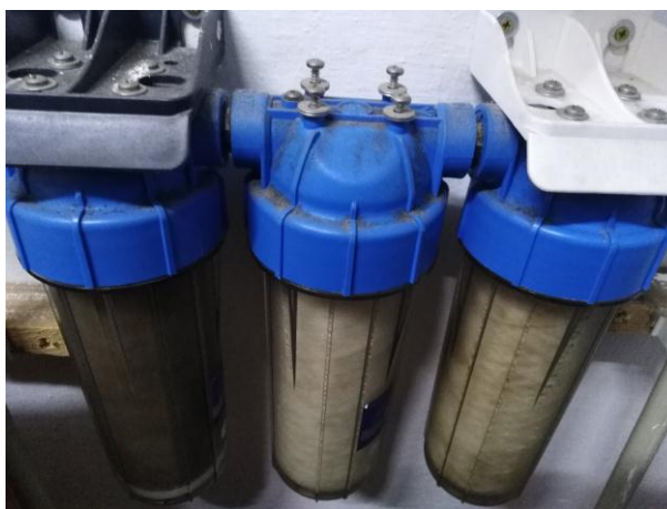
Рис. 2.3. Система потрійних фільтрів-колб для очищення води
