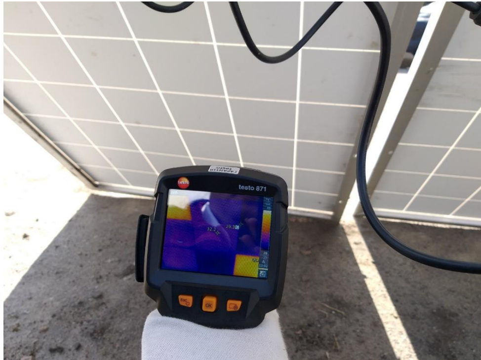
Рис. 3.1. Тепловізійне обстеження стану сонячних панелей
