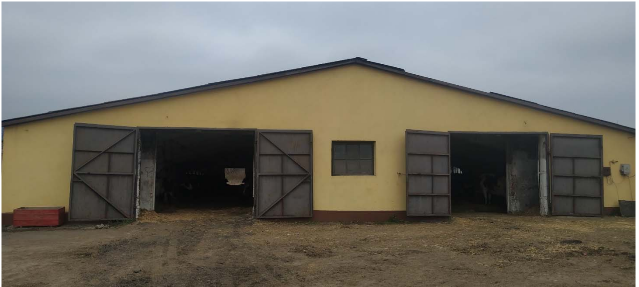
Рис. 2.1. Реконструйоване старе приміщення у с. Єрчики
