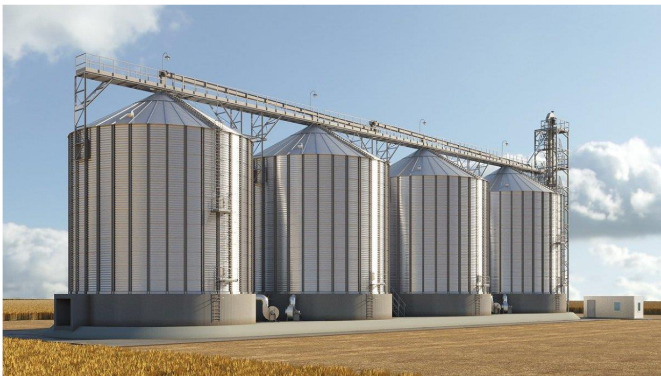
Рис.1.1. Силоси з активним вентиляванням матеріалу
