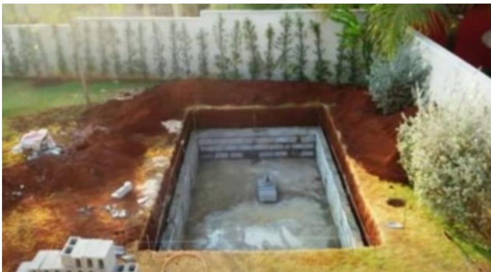
Рис. 3.6. Будівництво стін декоративного басейну
