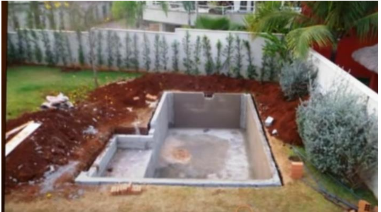
Рис. 4.7. Облаштування зони сходів до басейну
