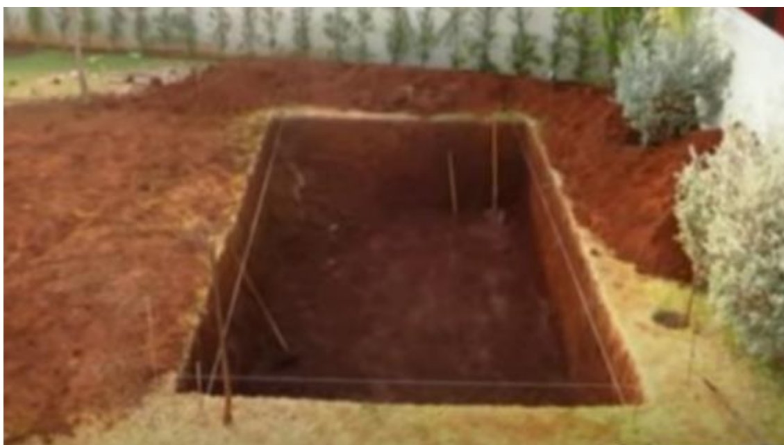
Рис. 3.4. Створення котловану для декоративного басейну на присадибній ділянці
