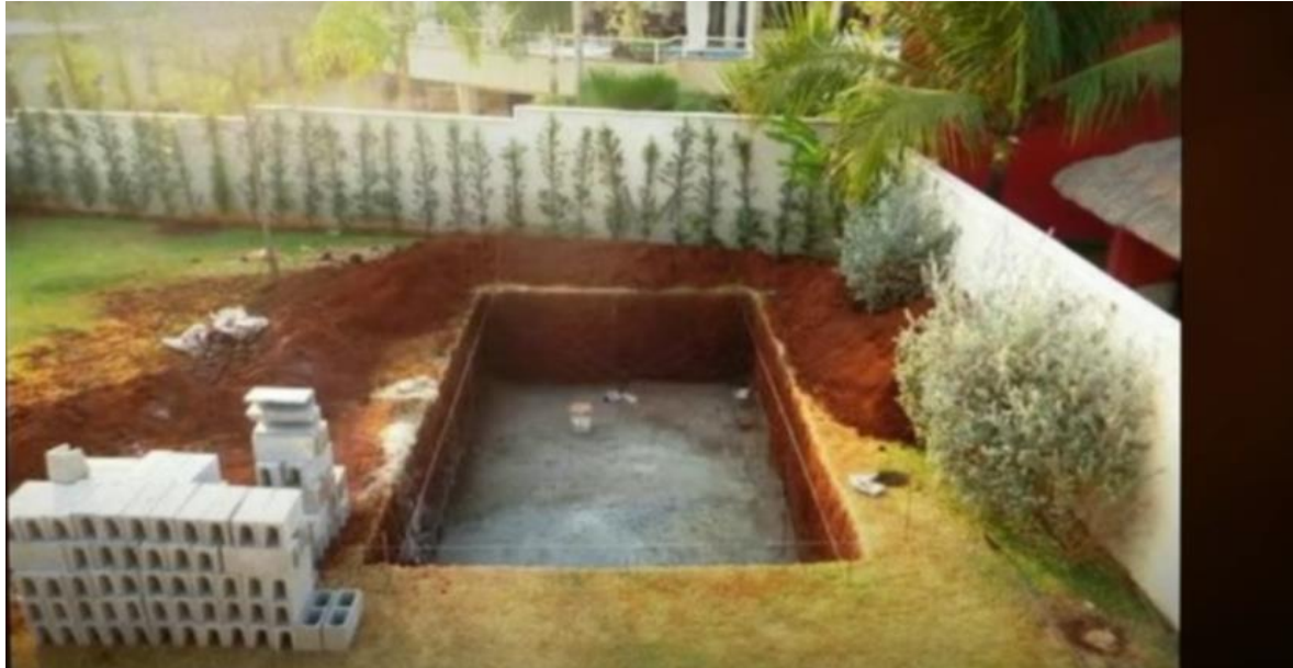
Рис. 3.5. Формування дна декоративного басейну на присадибній ділянці
