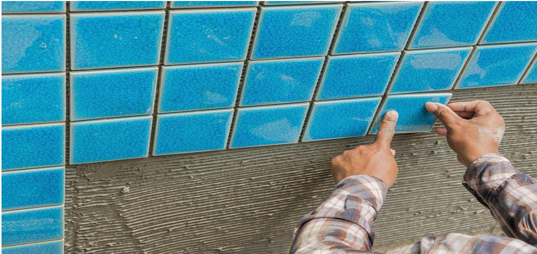
Рис. 3.8. Укладання мозаїчної плитки в басейні на присадибній ділянці
