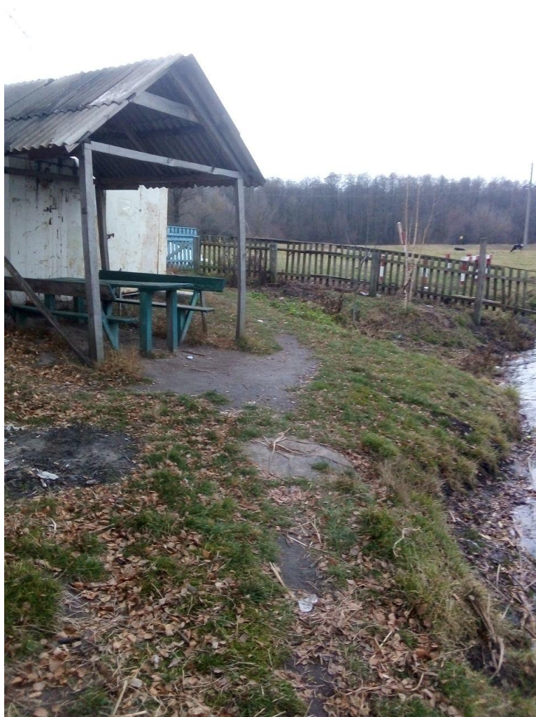
Рис. 3.5. Приміщення охоронців ставка
