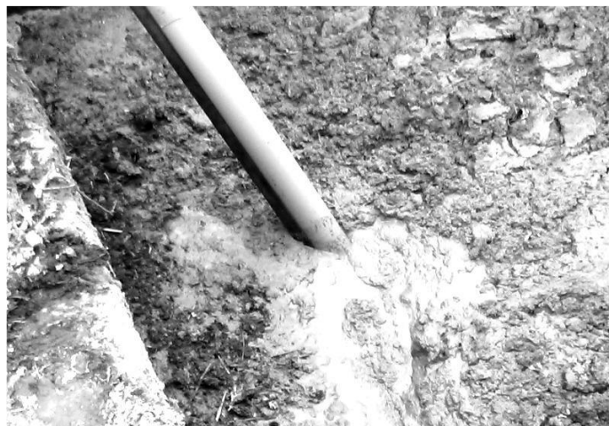
Рис. 3.9. Момент монтажу пристрою у помітній ямі птахофабрики
