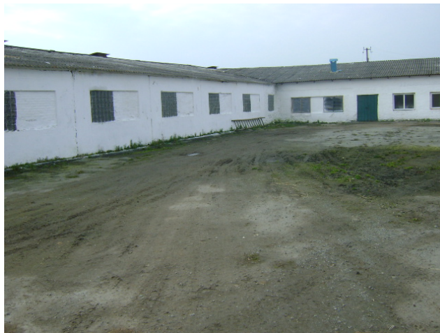
Рис. 2.1 Приміщення для утримання корів
