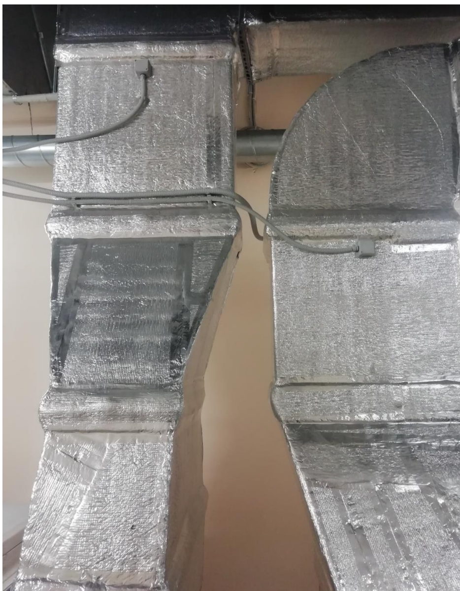
Рисунок 2.2. Утеплення припливних повітропроводів ізоляцією АЛЮФОМ.
