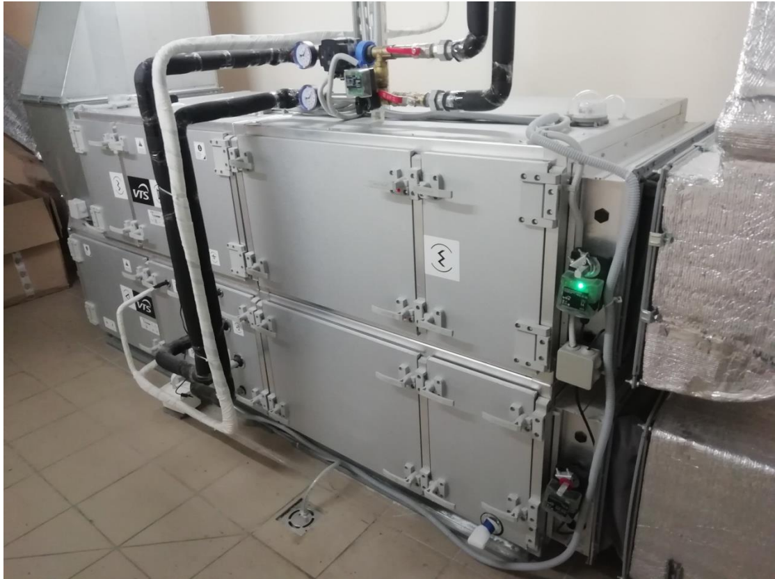
Рисунок 2.3. Вентиляційна установка типу Recovery Cross Vertical. Фірми VTS.
