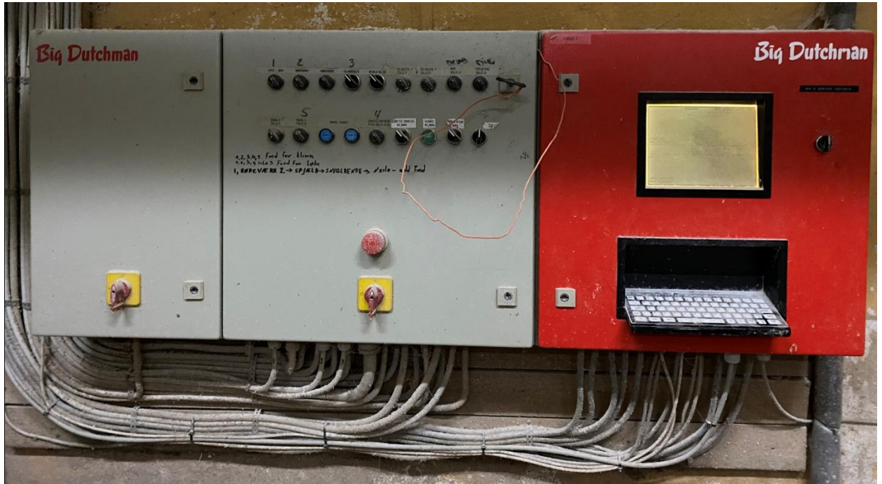
Рис. 3. Система контролю подачі кормів
