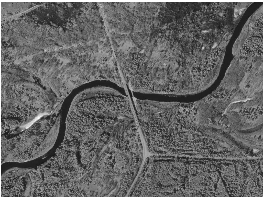
Рис. 3.22. Порушення інфраструктури на території Чорнобильського радіаційно-екологічного біосферного заповідника у 2022 р.
