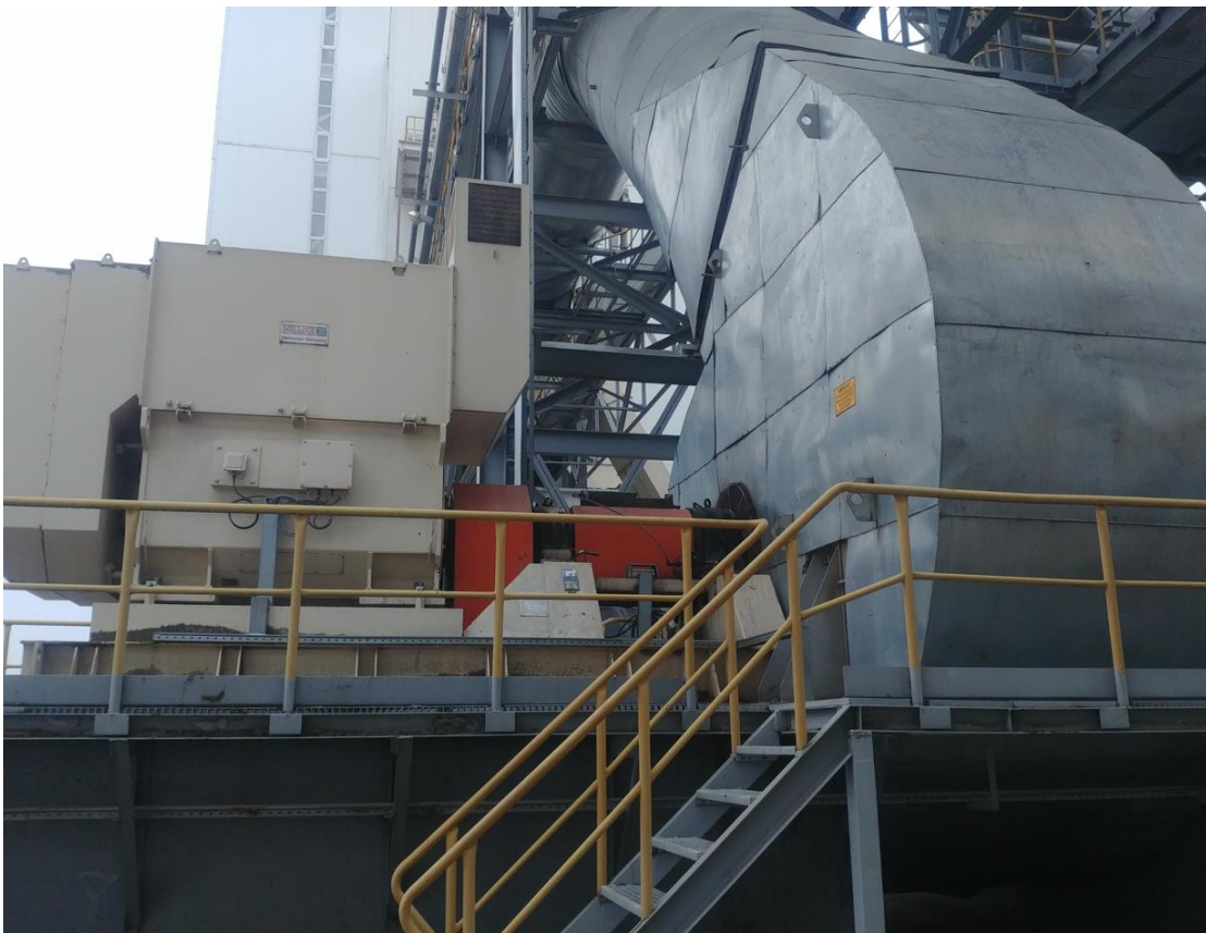
Рис.2.14. Загальний вигляд вентилятора аспіраційної системи
