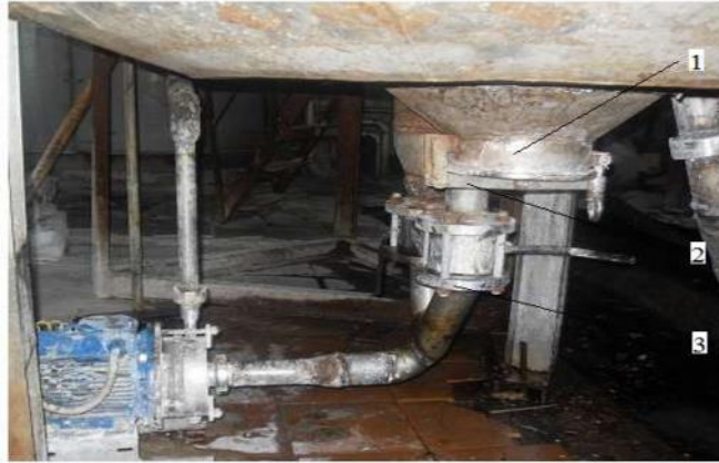
Рис. 3.6. Нижня частина ЗКЕ.
