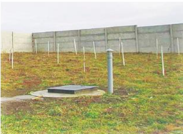
Рис. 5. Приклад заглибленого колодязя для розміщення устя свердловини
