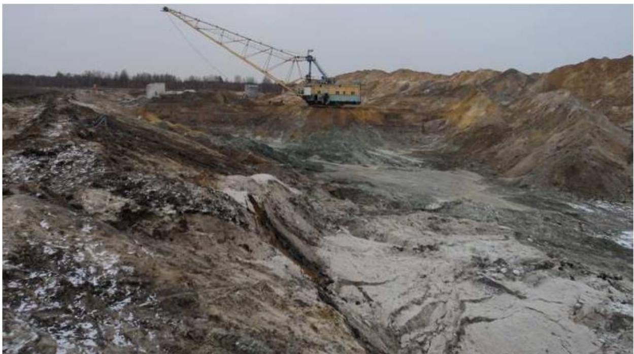
Рис. 2.2. Загальний вигляд Іршанського кар'єру по системі розробки «екскаватор-кар'єр»
