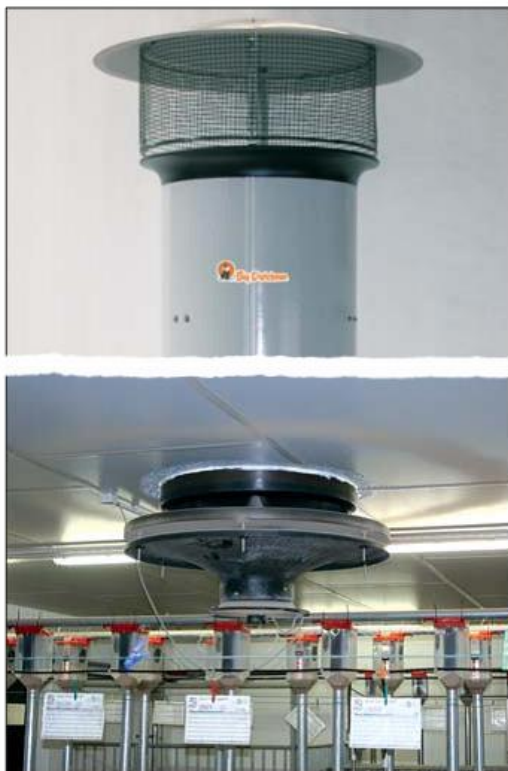
Рис. 2.5. Припливна шахта ФАС компанії "Big Dutchman"
