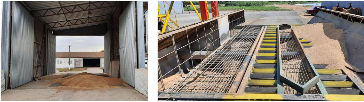
Рис. 3.10. Завальні ями агрегатів: а) крита (агрегат №1 та №3); б) відкрита (агрегат №2)
