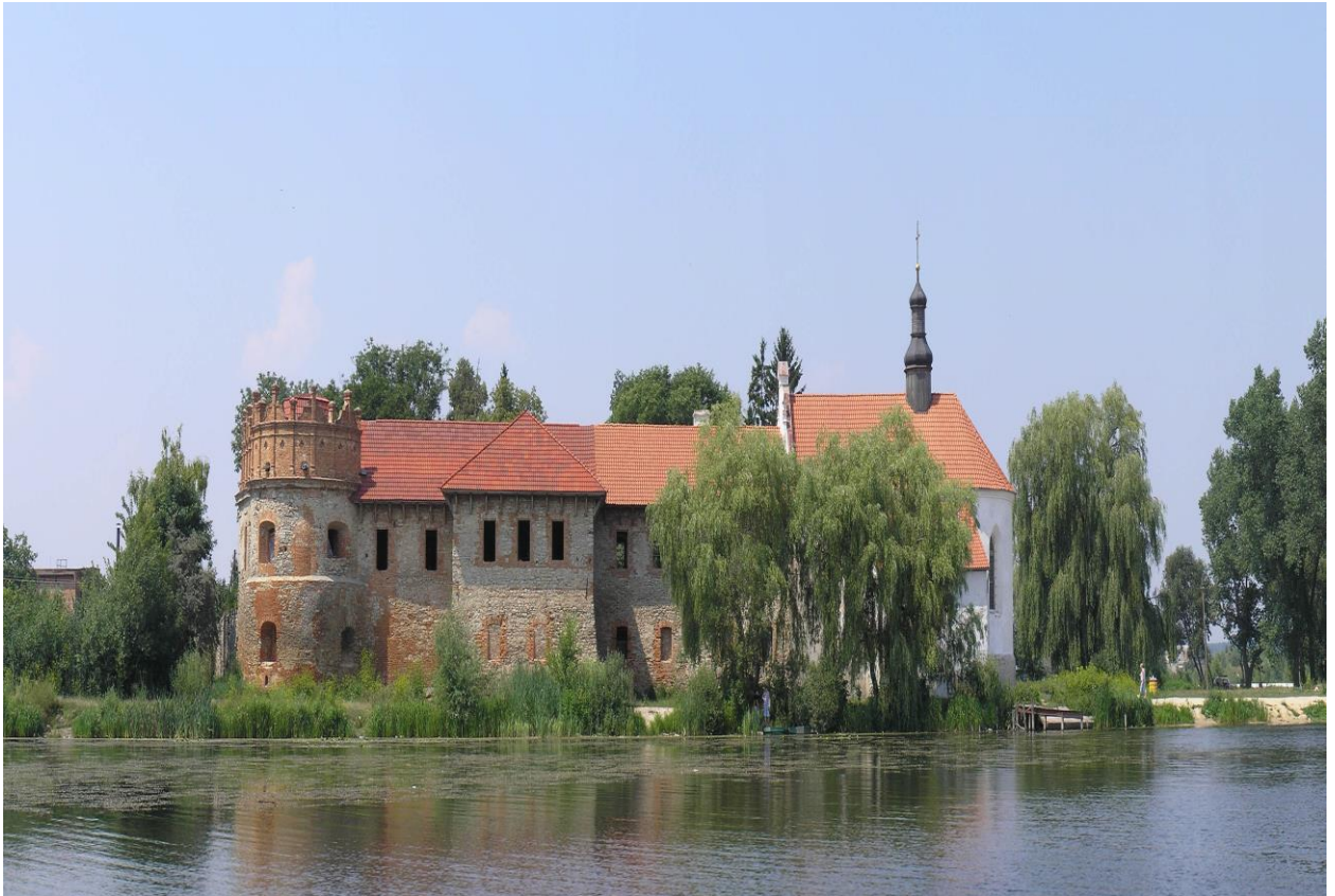
Рис. 3.7 Розміщення будівель на берегах річки Случ
