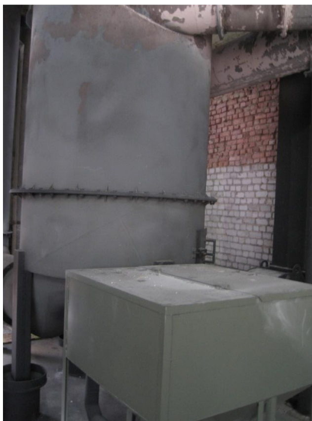
Рис. 10 Охолоджувач димових газів та подача сухого реагенту
