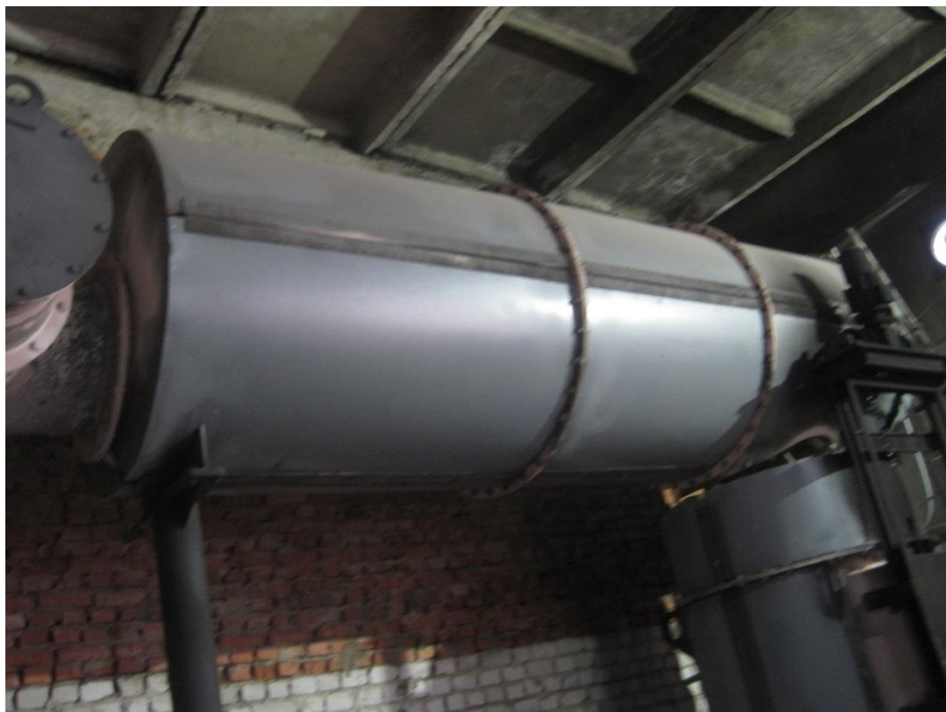
Рис. 9 Камера допалювання викидних газів
