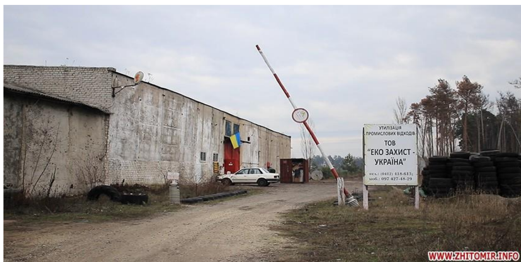
Рис. 2 Приміщення зі збору та утилізації відходів
