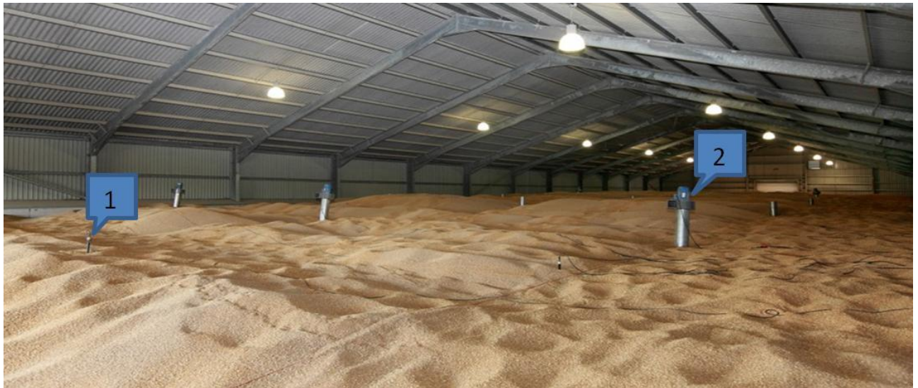
Рис. 1.2. Зберігання зерна в зерноскладі насипом: 1 – вентиляційні установки; 2 – датчики контролю температури зерна [3].
