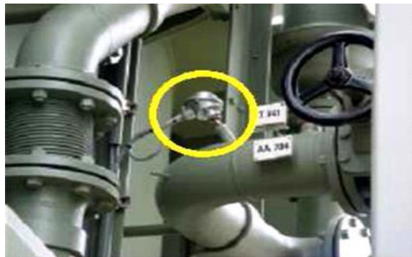
Рисунок 2.3. Температурний датчик для вимірювання оливи у системі охолодження
