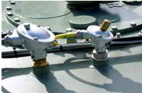
Рисунок 2.2. Температурний датчик для вимірювання оливи в баку
