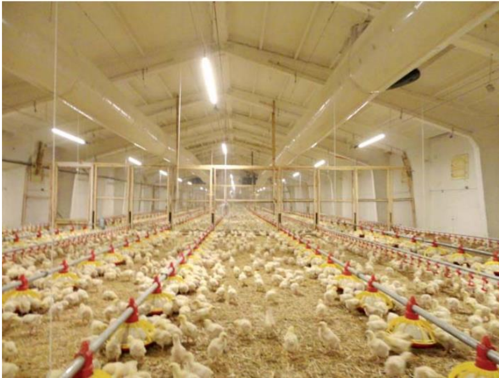
Рис. 4.1. Освітлення птахофабрики світлодіодами
