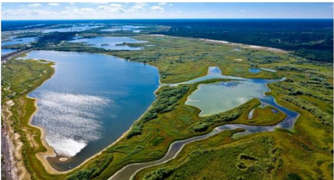
Рис.3.1. Виведення з експлуатації ставка-охолоджувача ЧАЕС
