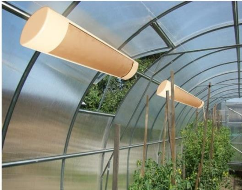
Рис. 2.8. Монтаж ІЧ-випромінювачів
