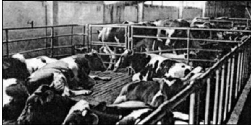
Рис. 2.1. Щілинна підлога для видалення гною.
