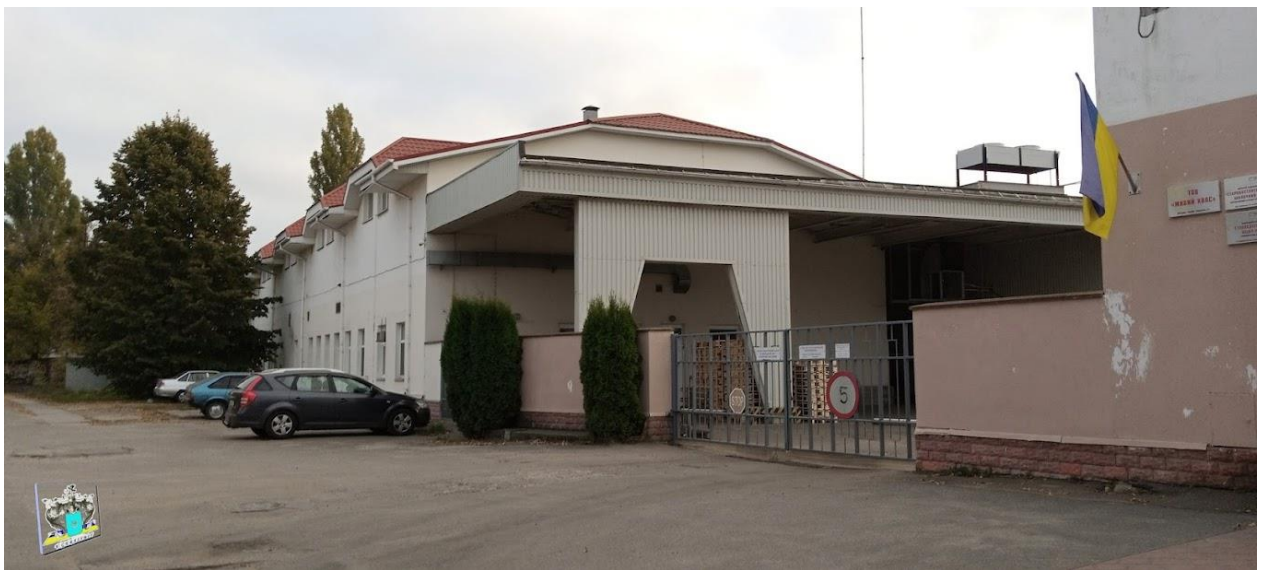
Рис. 2.1. Адміністративна будівля підприємства.
