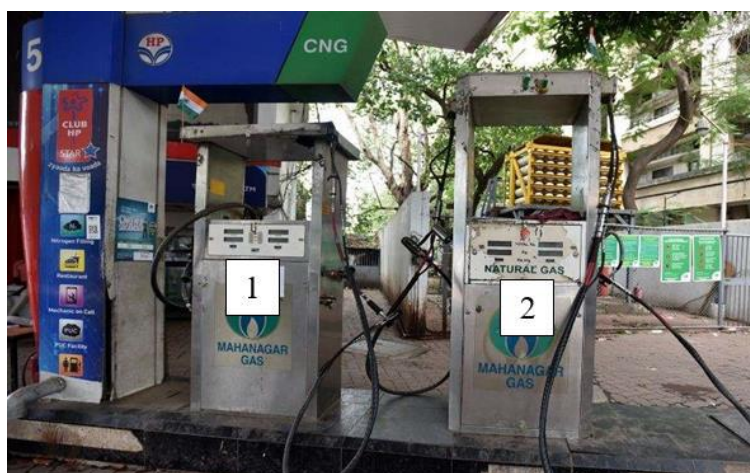
Рис. 1.3. Станція заправки біометаном в Індії. Подача біометану здійснюється в колонці № 1, чистого метану – в колонці № 2.
