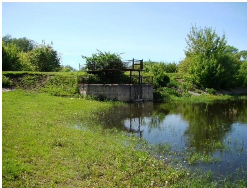
Рис. 2.3 Водоскид р. Білка Радомишльський район Житомирська область
