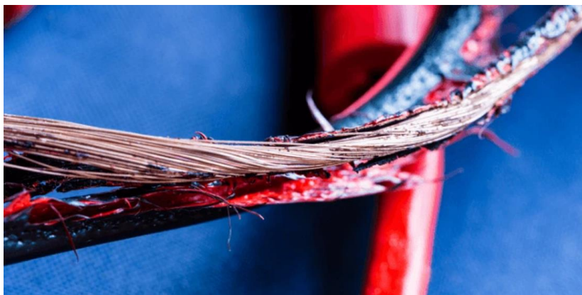
Рисунок 1.5 – Дефект ізоляції в наслідок дії високих температур
