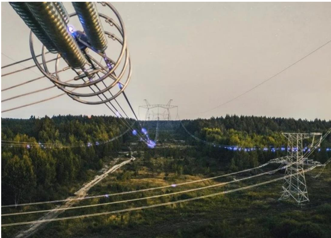
Рисунок 1. Вид коронного ефекту на повітряній ЛЕП
