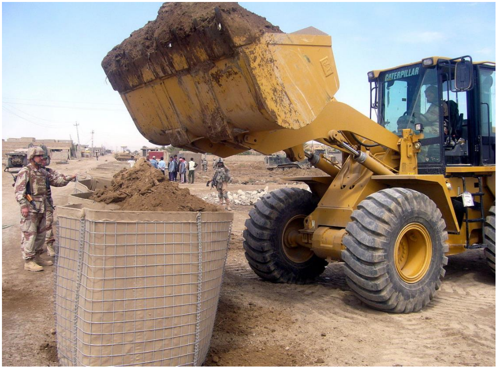
Рис 3.4 Наповнення Бар'єру HESCO [12]
