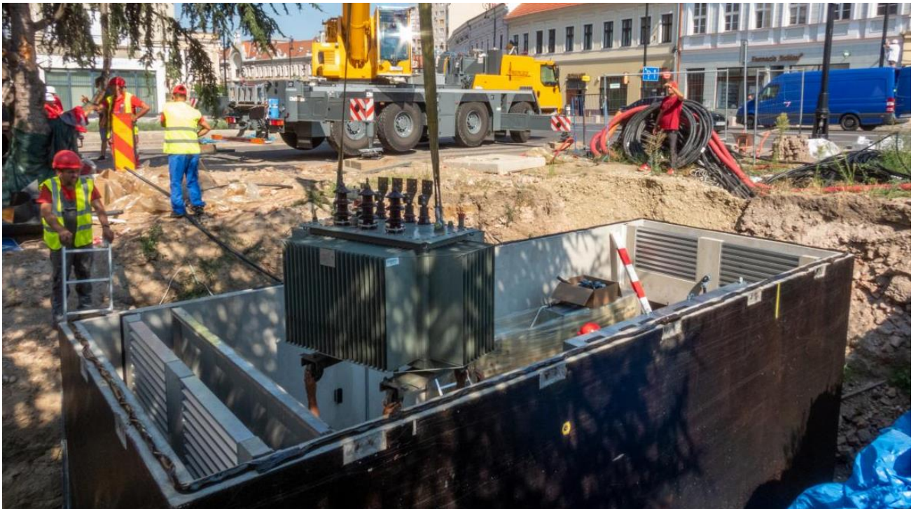
Рис. 3.5 Комплектування одного із подібних сховищ « GRITEC » енергетичним обладнанням [7]
