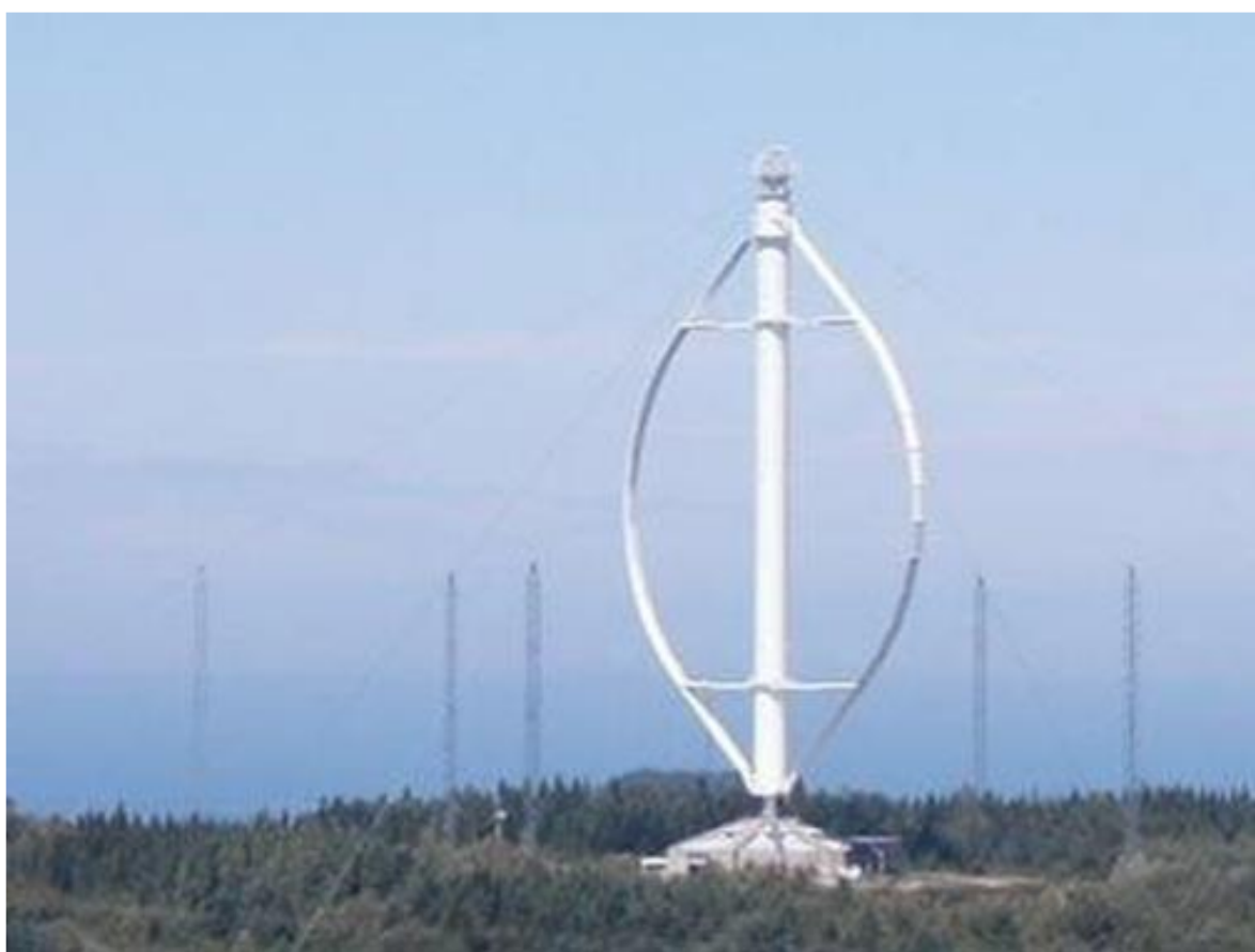
Рис. 6 - Турбіна Дар'ї
