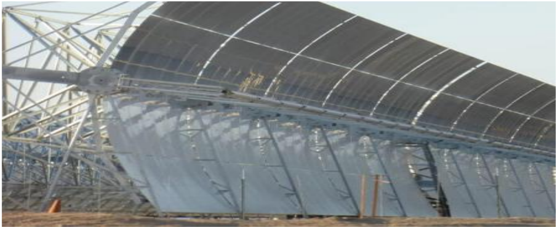
Рис. 11 – Параболоциліндричні концетраторні СЕ
