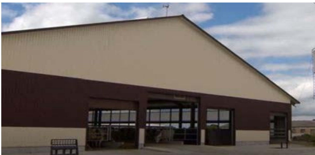
Рис.2. Приміщення для утримання тварин с. Квітневе
