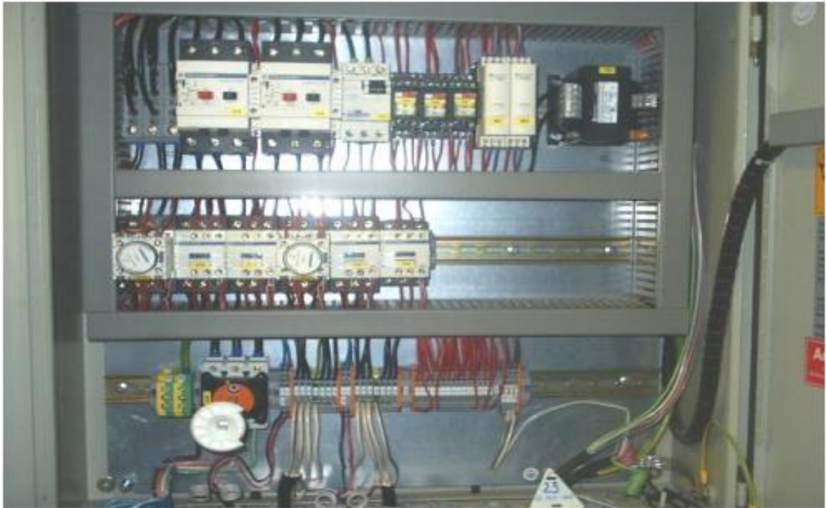
Рисунок 1.5. – Щит керування насосами та димососом
