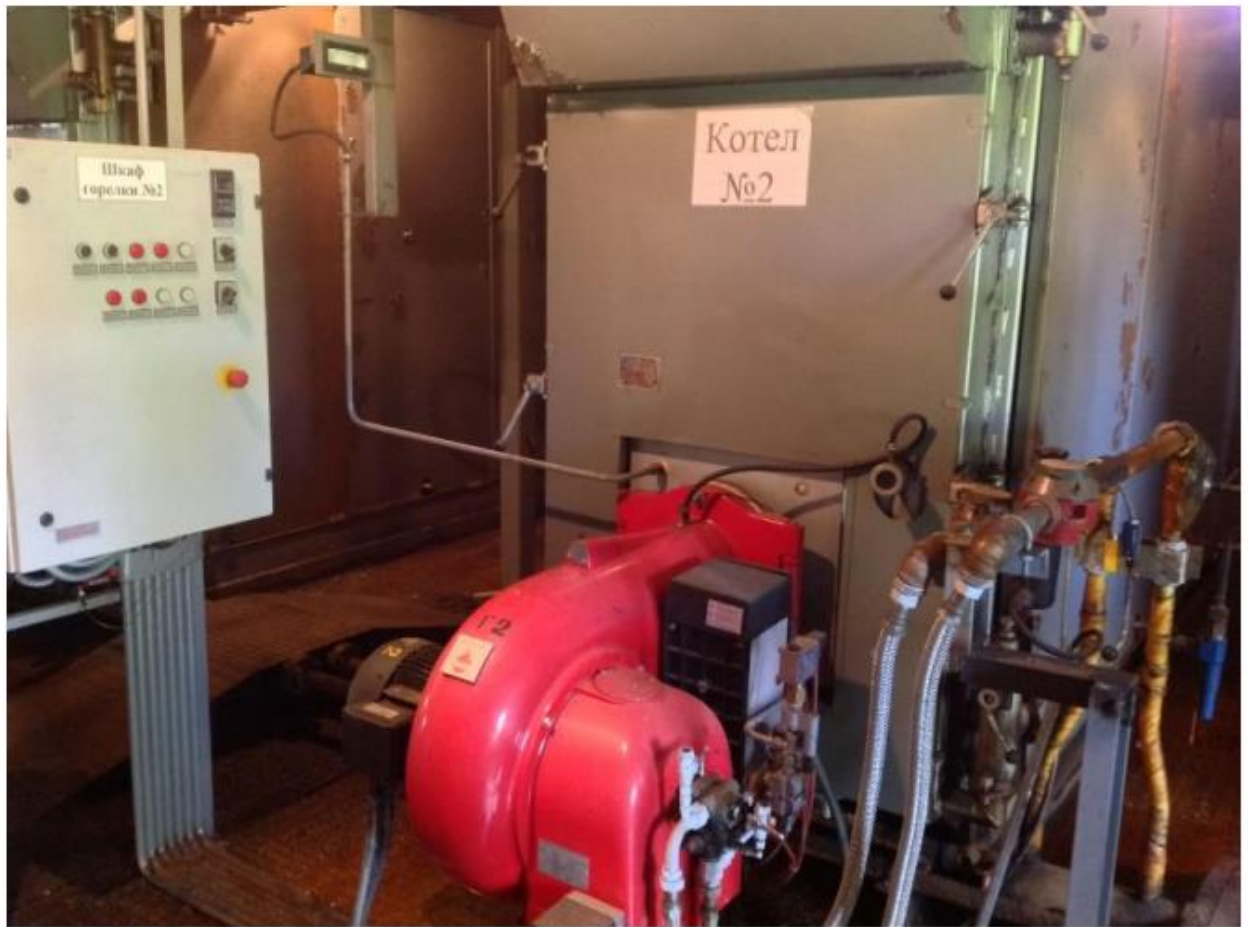
Рисунок 1.2. – Шафа управління пальником фірми Weishaupt
