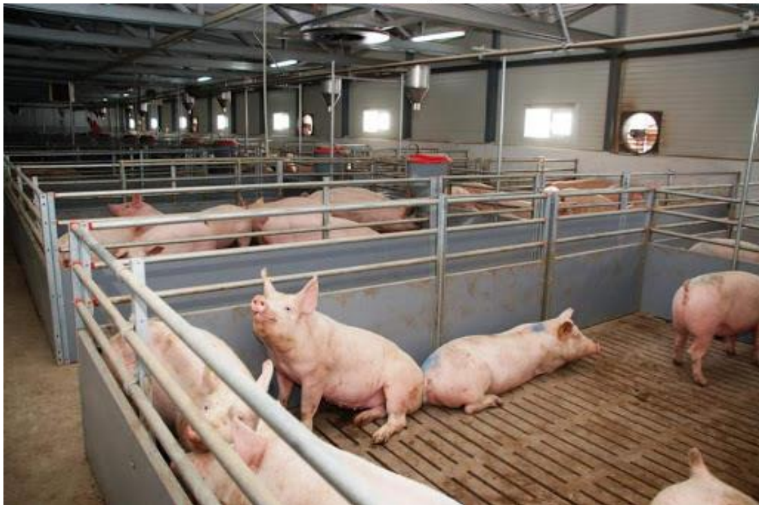
Рис. 1.3. Бетонна щілинна підлога над поперечними каналами
