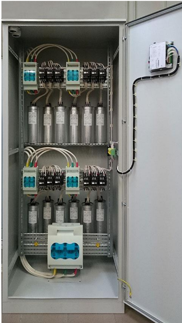
Рисунок 3.1 – Установка для компенсації РП з авторегулюванням
