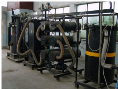
Рис. 3. Газогенераторна станція потужністю 100 кВт, що працює на відходах деревини (Китай)
