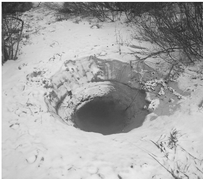
Рис. 3. Кратер, що утворився внаслідок вимивання ґрунту, с. Гулянка Коростенського району, 2014 р.
