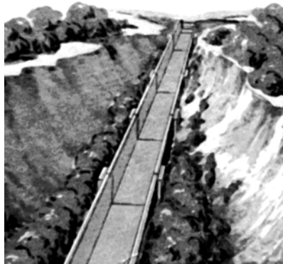
Мал. 4.69. Спорудження лотоків через дно яру
