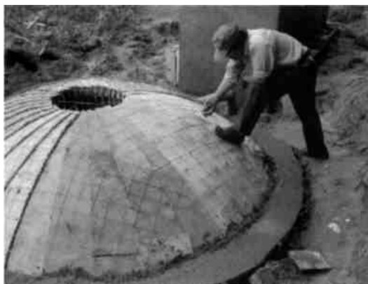
Будівництво біогазової установки
