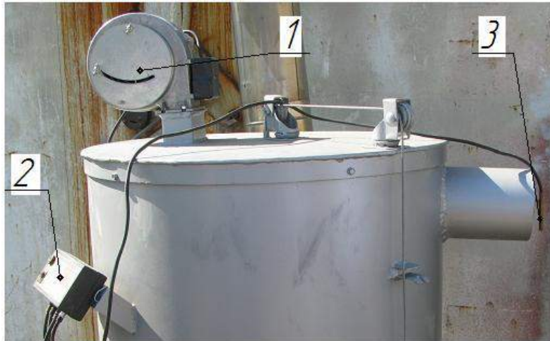
Рис. 4.14. Система керування котлом:
