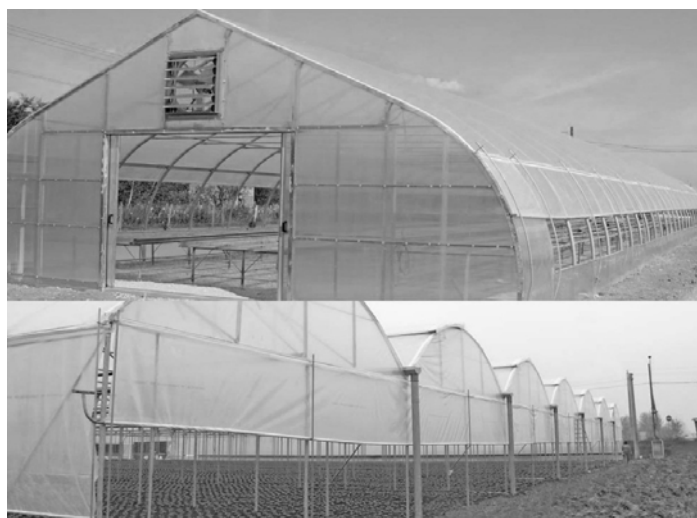
Рис. 2. Вентиляція через фронти конструкції теплиці
