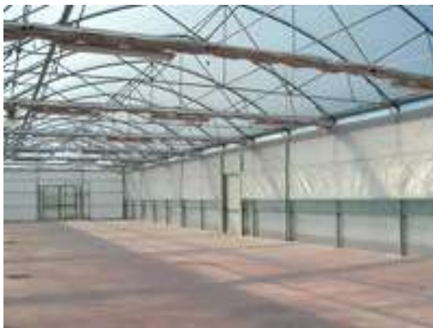
Рис. 1. Загальний вигляд систем зашторювання в теплиці.
