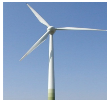
Рис. 2. Трьохлопатевий вітрогенератор з горизонтальною віссю обертання.
