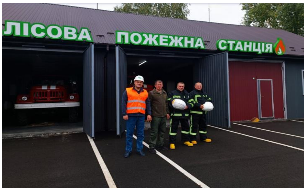
Рис. 3.10. Лісова пожежна станція Овруцького СЛГ
