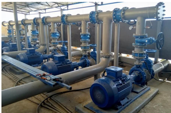
Рис. 1.1. Система консольних насосів для поливу полів [1, 6, 12, 18].
