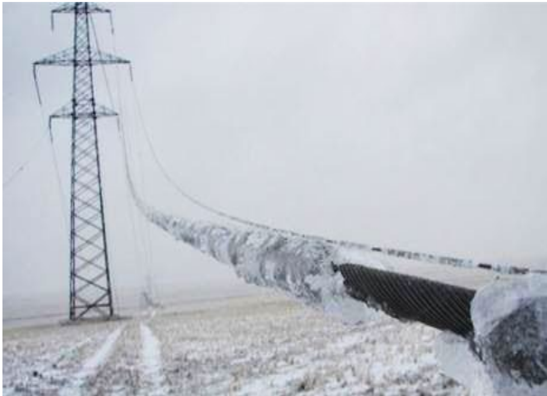
Рисунок 9. – Провис дроту з-за льоду
