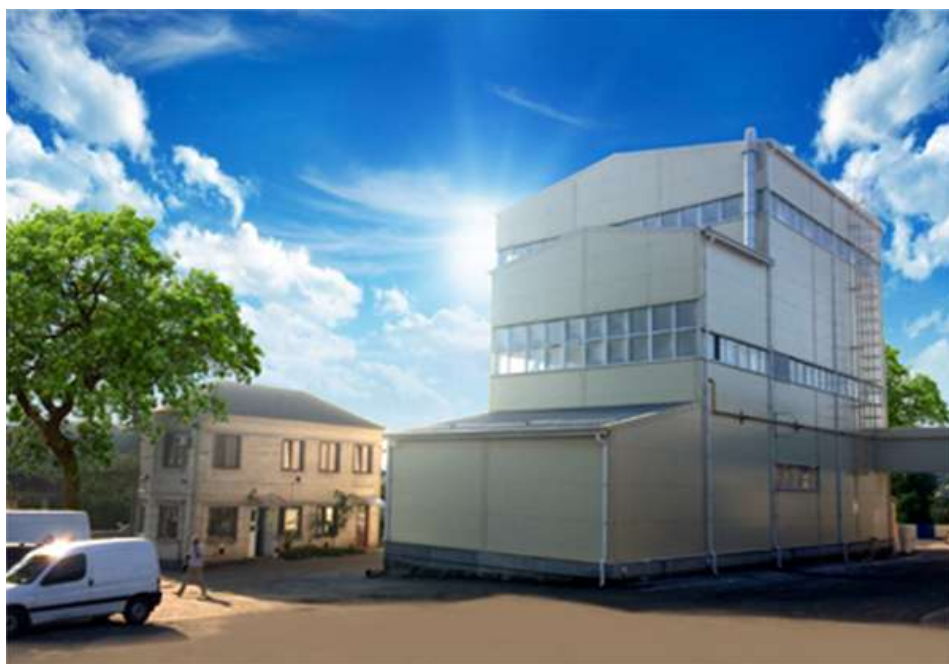
Рис. 2.1.1. Будівля ТОВ «Шаргородський маслозавод»
